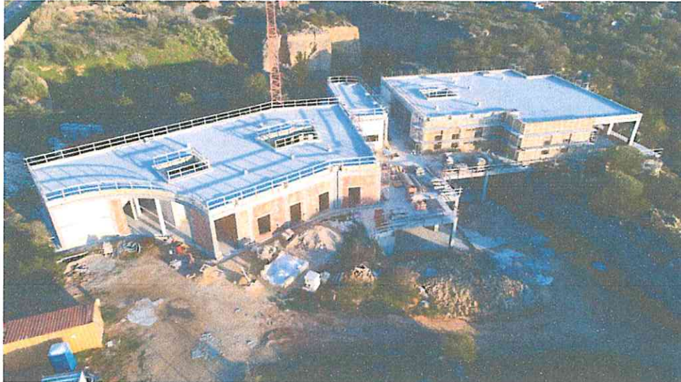
Il Centro Ilma in fase di ultimazione a Gallipoli.
