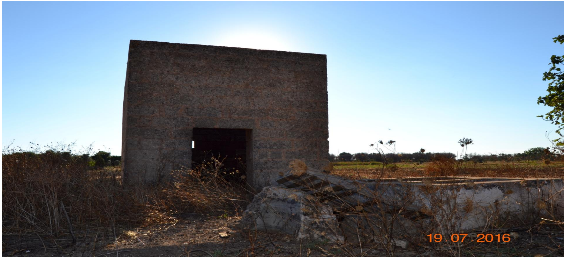
Fig. 2 Particolare in cui si può verificare la presenza di un vecchio fabbricato rurale di circa 14 mq di fronte al quale è presente un antico pozzo scavato a mano.
