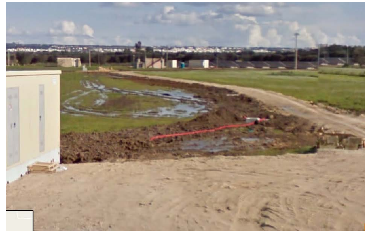
Foto 3.15 - Impianto fotovoltaico in campo
