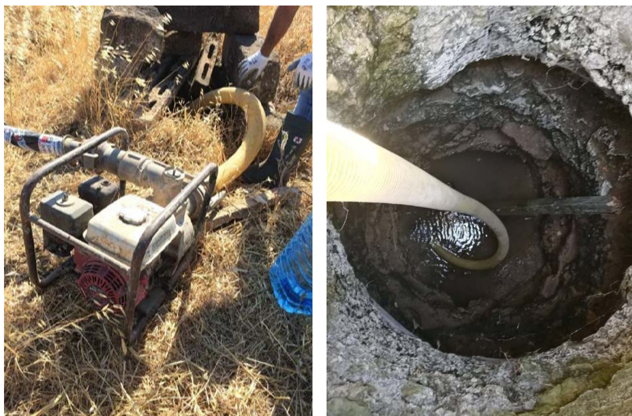
Foto e, f - Prova di pompaggio sul pozzo P8 (Maggio 2017).
