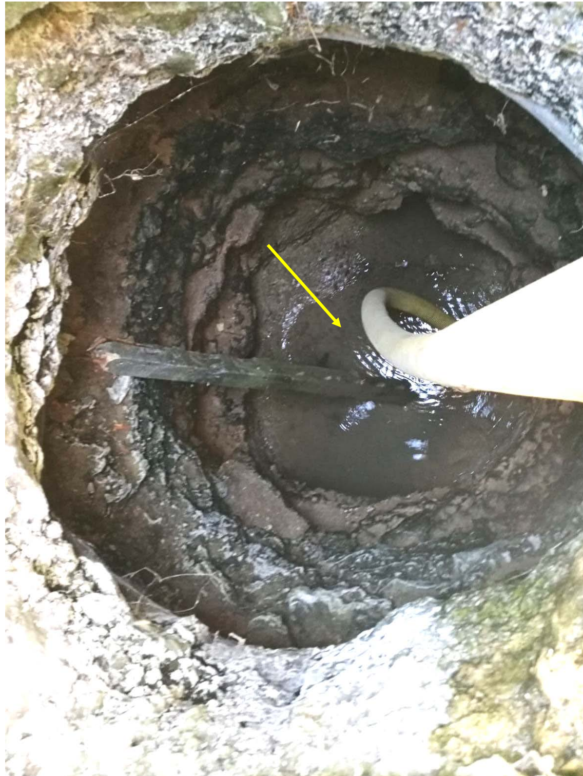
Foto a – Particolare relativo al pozzo P8, ma comune a tutti gli altri: risulta attestato per circa 0,5 metri nel substrato argilloso impermeabile (freccia), allargandosi alla base e fungendo da “cisterna”, così da raccogliere sempre circa mezzo metro di acqua stagnante e melma anche quando la falda è del tutto assente.
