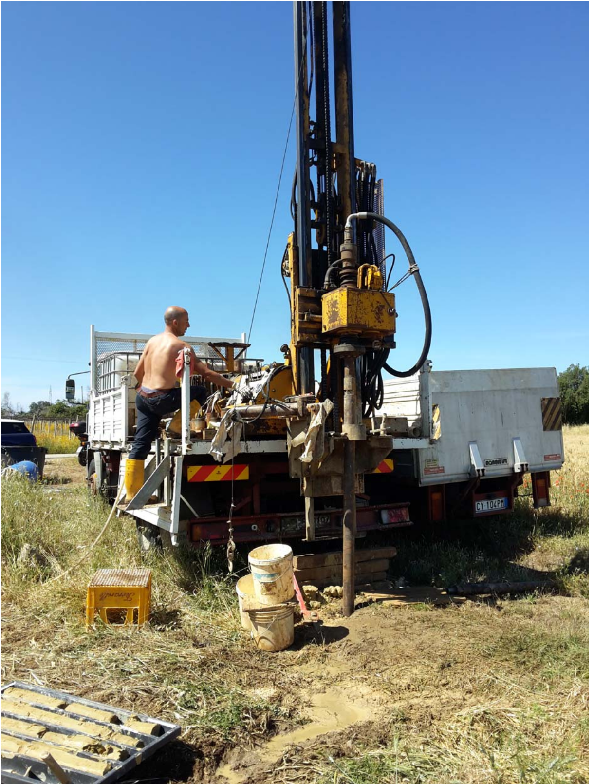
Esecuzione del sondaggio S1
