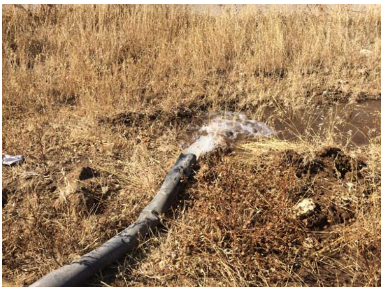
Foto 7.2÷7.4 - Prova di pompaggio sul pozzo P7 (Giugno 2017).
