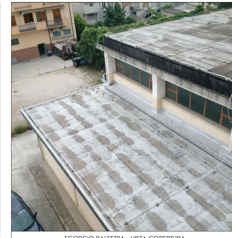
SCORCIO PALESTRA - VISTA COPERTURA
