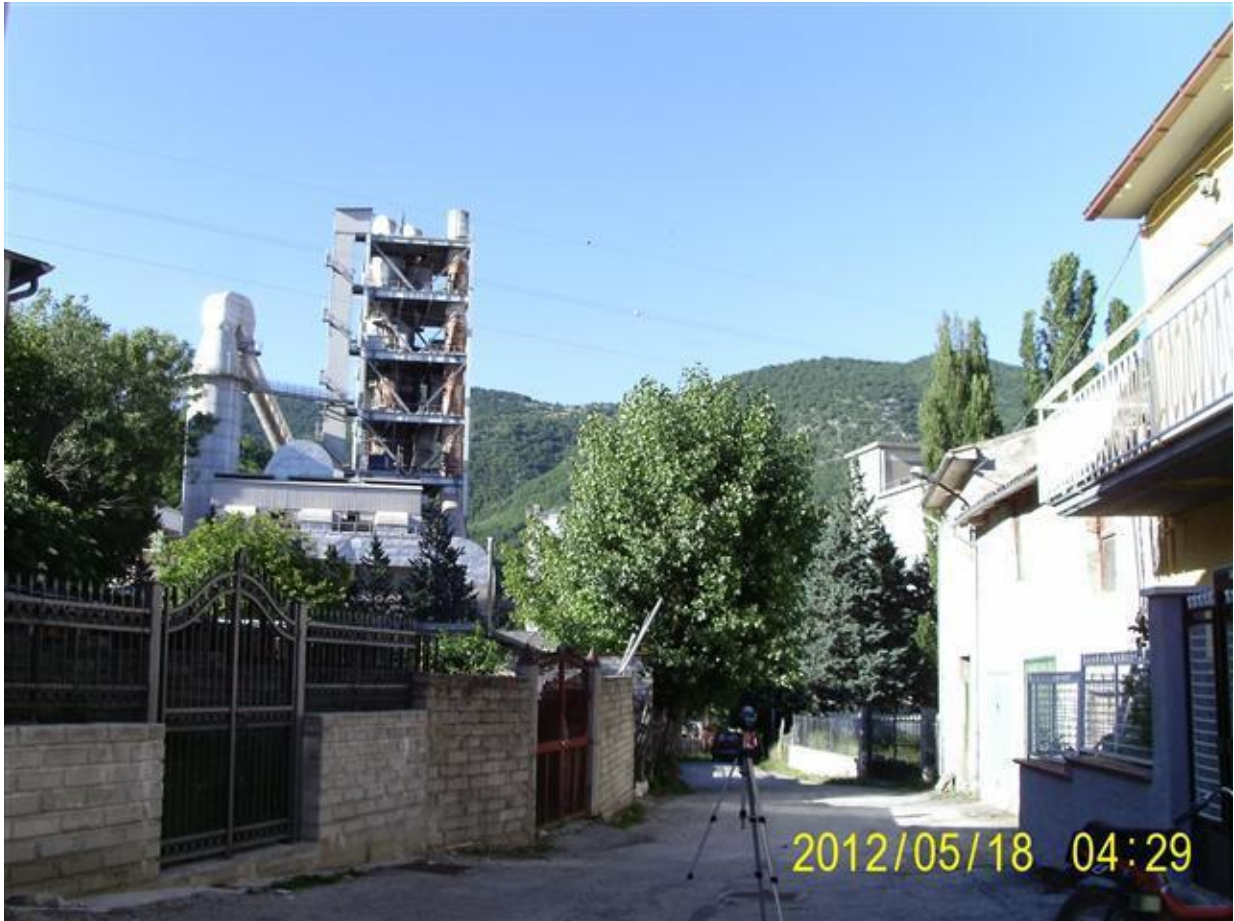
Punto di controllo n. 5: via Del Fosso civico n. 24 ricettori civili abitazioni
