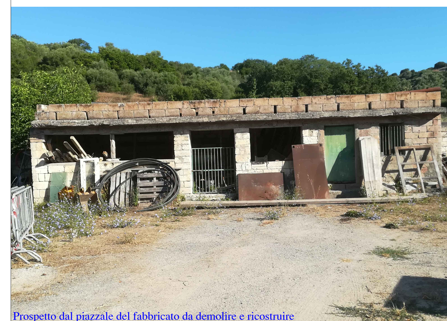
Prospetto dal piazzale del fabbricato da demolire e ricostruire
