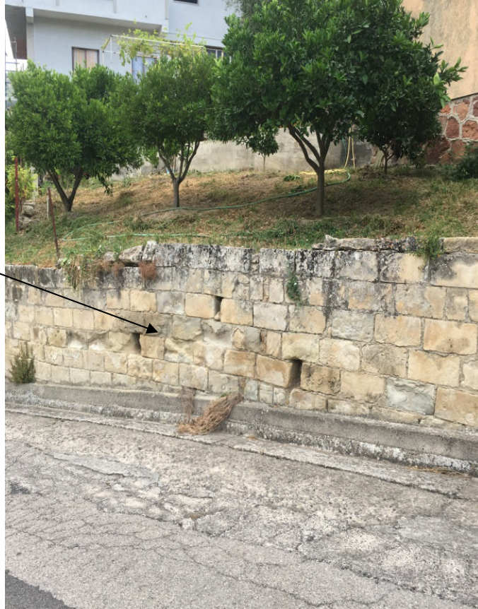
FOTO 4 - PARTICOLARE DEL MURO IN BLOCCHI DI TUFO
