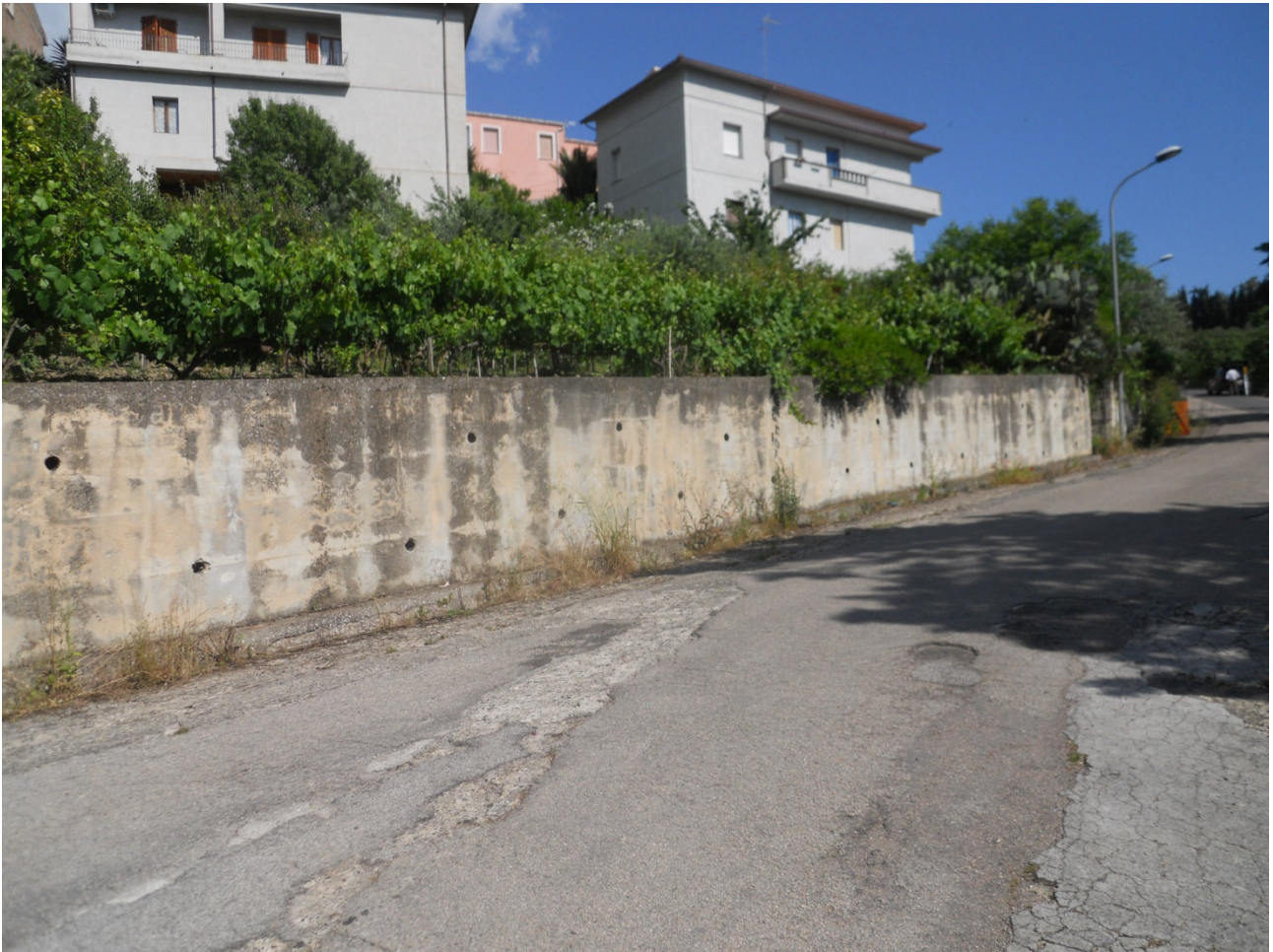
FOTO 5 – MURO IN CLS CICLOPICO UBICATO ALL'INCROCIO TRA VIA S'ISCAMEDDU E SS.292
