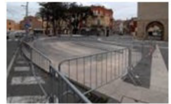
RIMOZIONE AREA DI CANTIERE - S'ISCAMEDDU
