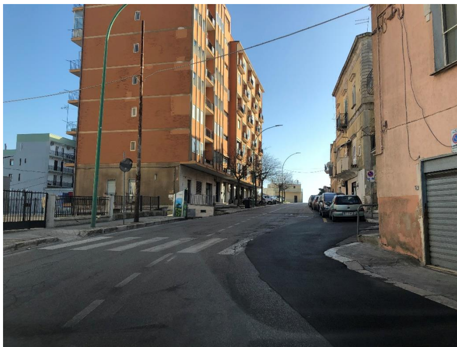
Fotografie 9 e 10 - Rilievi della Città di Mottola (TA) – viale Giuseppe Turi all'intersezione con via Dante a destra e via Pineta a sinistra; in evidenza la ridotta larghezza dei marciapiedi laterali, le aree di sosta laterali e la configurazione in salita dell'asse stradale.
