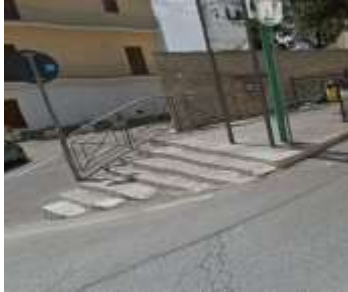
Foto del rilievo
