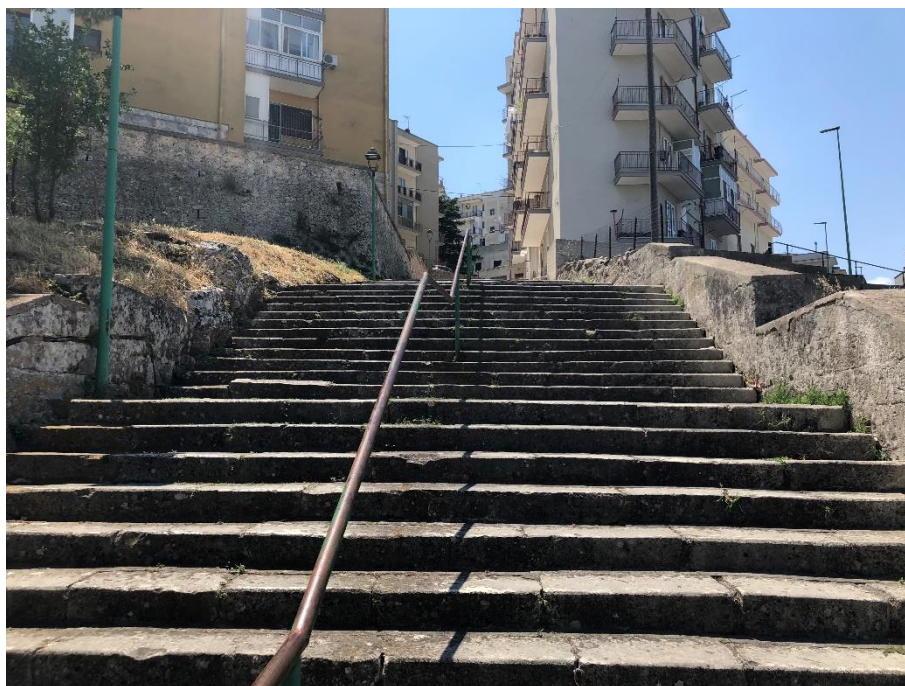
Fotografie 25 e 26 - Rilievi della Città di Mottola (TA); in evidenza la presenza di scalinate di antica realizzazione che caratterizzano l'intera struttura della città di impossibile accessibilità per persone con disabilità motorie.
