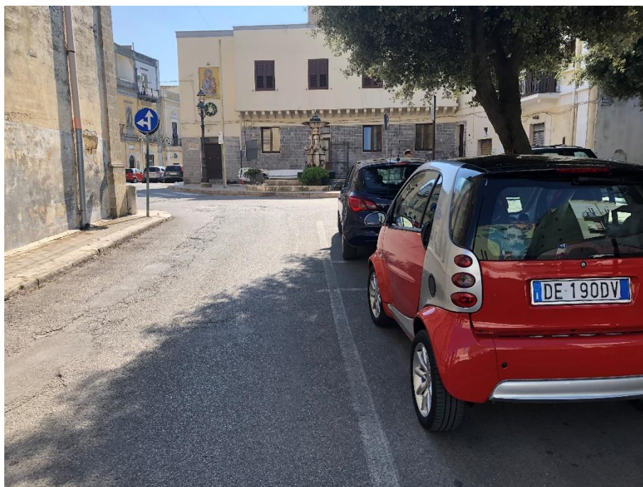
Fotografie 37 e 38 - Rilievi della Città di Mottola (TA); in evidenza la conformazione di Piazza Plebiscito e della viabilità interna di corso Vittorio Emanuele II; in evidenza la presenza di aree di sosta e la ridotta larghezza dei marciapiedi laterali in prossimità delle intersezioni stradali.
