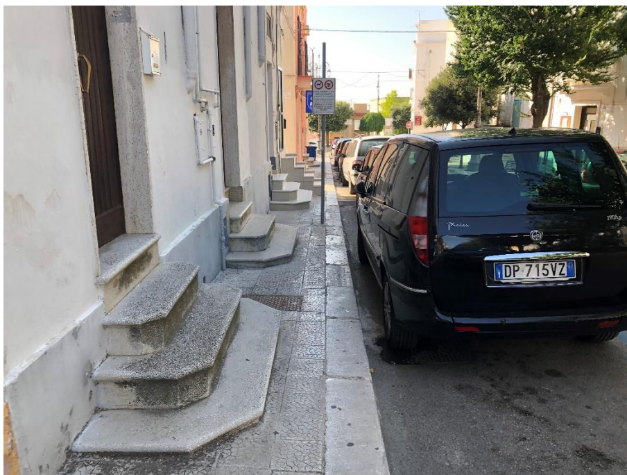
Fotografia 44 - Rilievi della Città di Mottola (TA); in evidenza la presenza di marciapiede con scalini laterali di accesso agli interni dei fabbricati presenti che risultano esempi di barriere architettoniche. Ripresa in prossimità con l'intersezione di via Gian Battista Vico.
