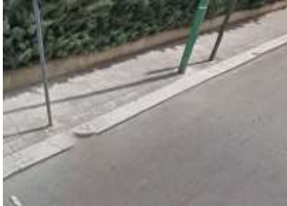
Foto del rilievo
