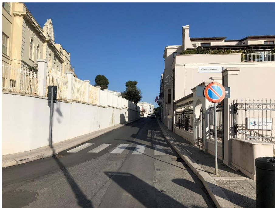
Fotografie 15 e 16 - Rilievi della Città di Mottola (TA) – via Risorgimento (foto n. 15); in evidenza la ridotta larghezza dei marciapiedi laterali e la configurazione in salita dell'asse stradale; nella foto n. 16, ripresa di via Risorgimento all'intersezione con la viabilità principale Corso Vittorio Emanuele; in evidenza la presenza di scivoli realizzati per le barriere architettoniche privi di appositi attraversamenti pedonali in sicurezza.
