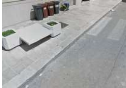
Foto del rilievo
