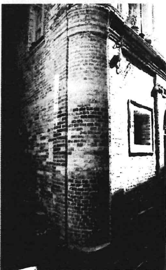
Via del Pozzo
