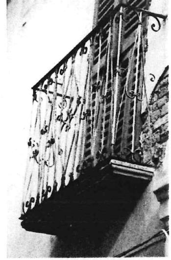
Via del Pozzo
