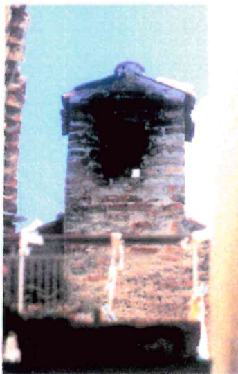
Via del Pozzo
