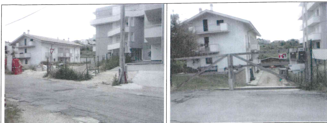
Foto stato di fatto. Particolare dell'accesso alla particella 661 e dello stato della viabilità
